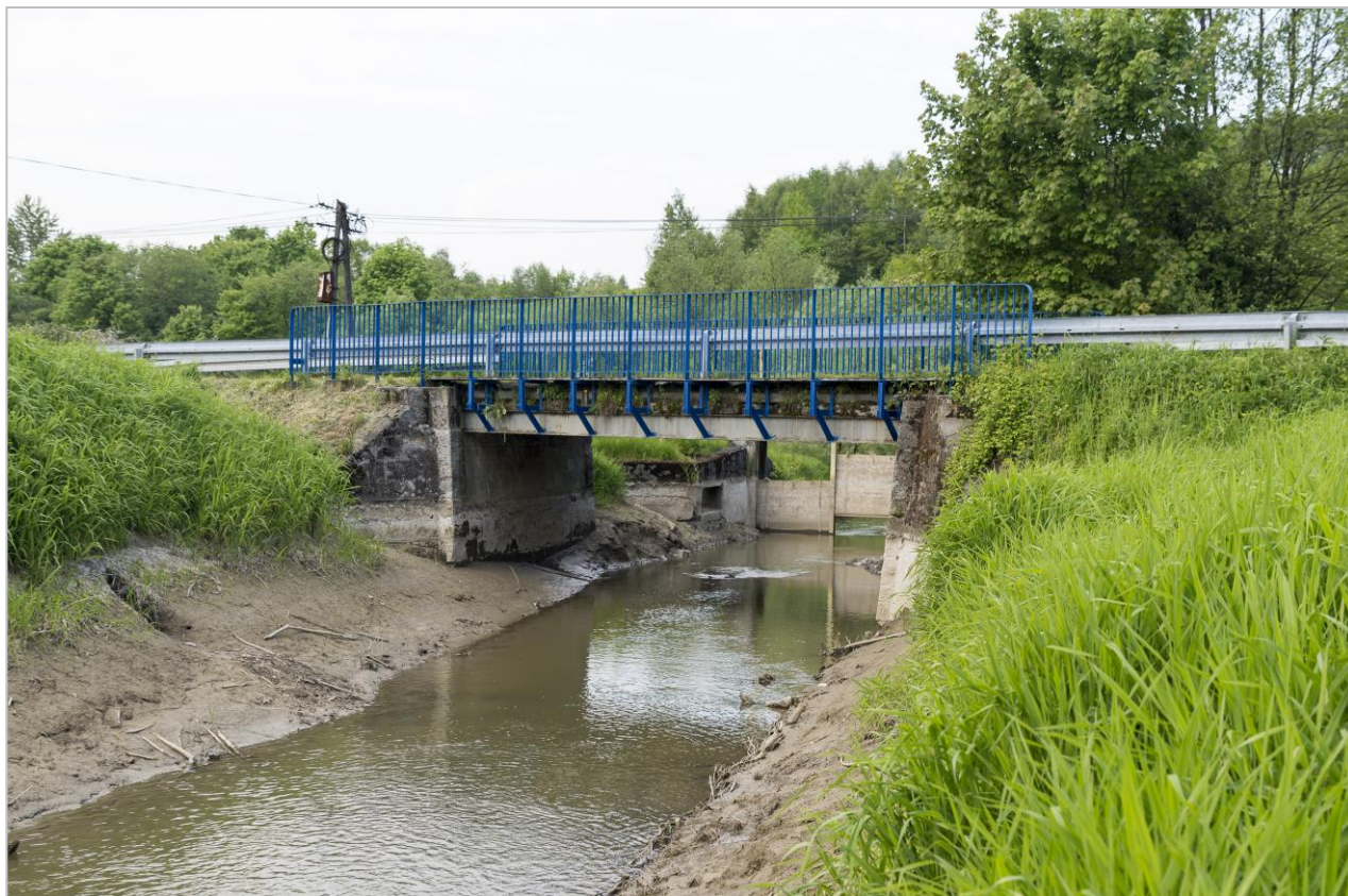
Fot. 1 Widok mostu od strony górnej wody.
