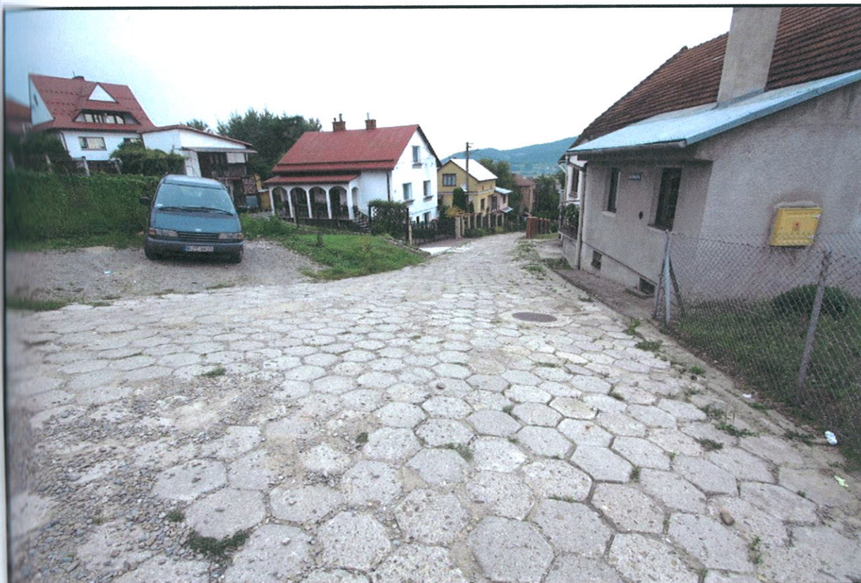
Fot.17. Ulica Słoneczna, widok w kierunku północnym.
